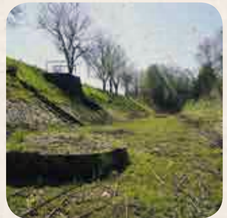
Rückhaltebecken auf dem Flughafengelände für Niederschlagswasser mit Versickerungsschächten
