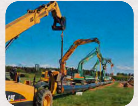
Bau Medientrasse für Fernwärmeleitung
