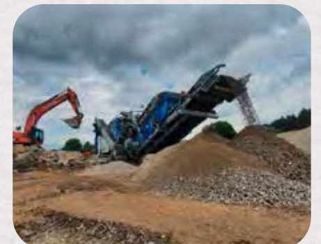
Betonrecycling am Flughafen Memmingen
