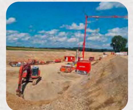
Bau eines neuen Regenrückhaltebeckens
