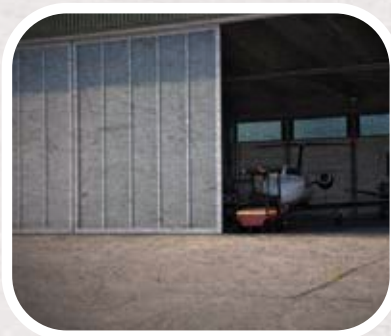
2022 Bau eines Flugzeughangar
